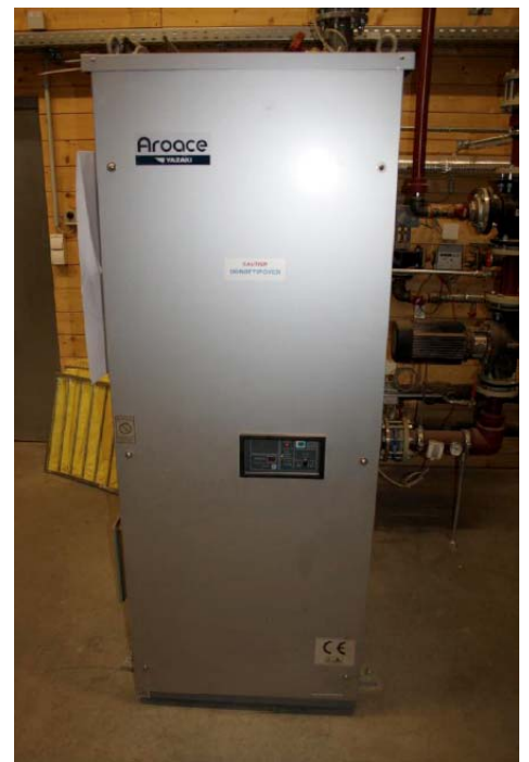
Yazaki Absorptionskältemaschine
