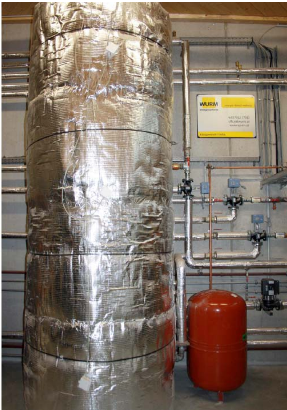
Pufferspeicher Spezialanfertigung mit Schafwolle gedämmt
