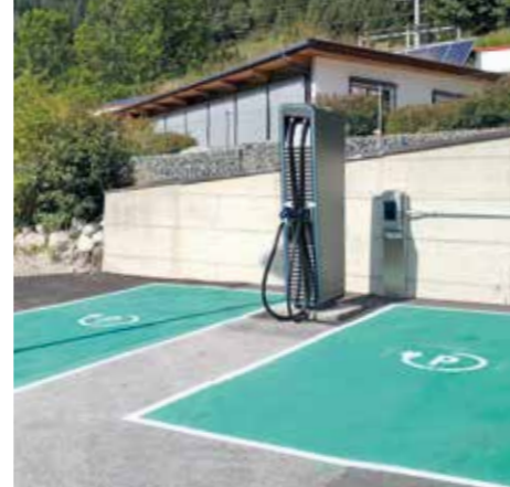
Wir haben unseren Ladeplatz bei der Firma um einen Hypercharger erweitert. Ab sofort stehen zwei CCS Stecker mit 100 kW zur Verfügung.
